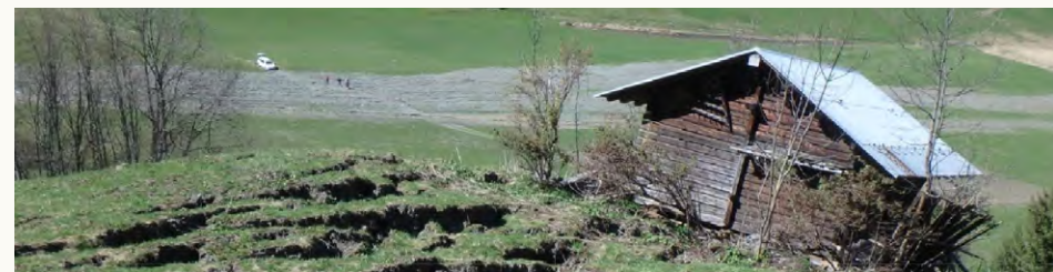
> Glissement de la Joux à Beaufort en avril 2016 - photo : ONF/RTM
