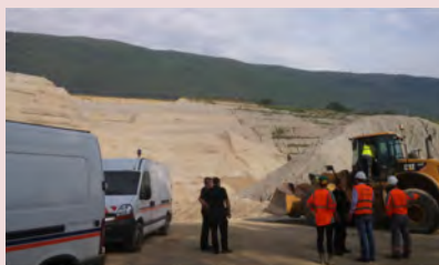
> Opération de déminage en 2017 - photo : préfecture de la Savoie
