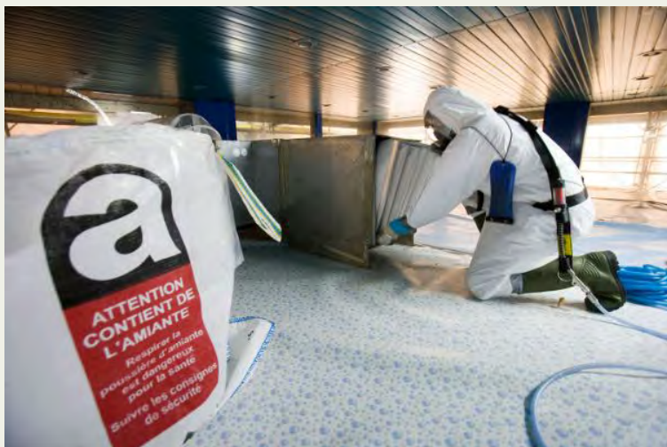
> Chantier de désamiantage - photo : INRS
